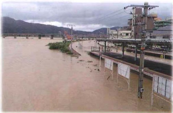
平成25年9月の台風18号で浸水した駅北
