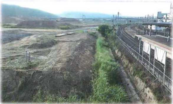
橋が隠れるほど高く土砂が積まれた現在の駅北
